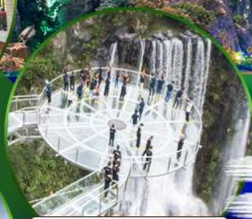
สะพานแก้วภูหลงเซี่ยะ
