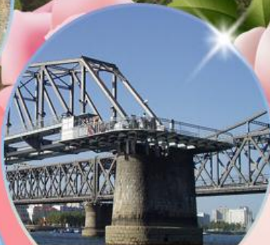
สะพานขาดตานตง
