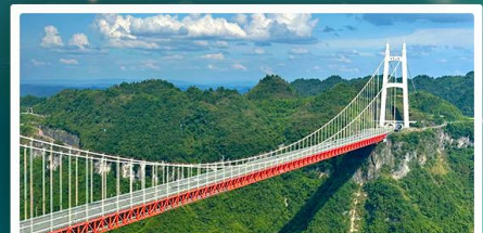
สะพานอ้ายจ้าย
