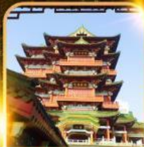
หอเก๋งหวังเก๋อ
